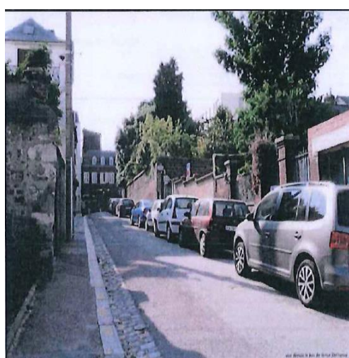
Extension d'une maison Individuelle PCMI8 Photographie du terrain dans son Environnement lointain
