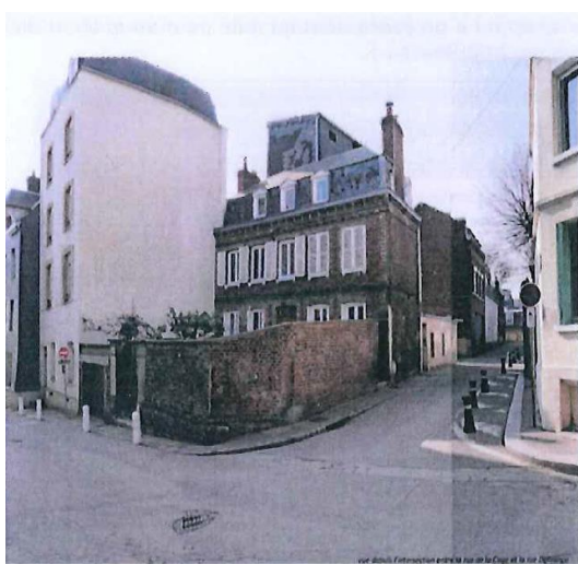
Extension d'une maison Individuelle PCMI 7 Photographie du terrain dans son Environnement proche
