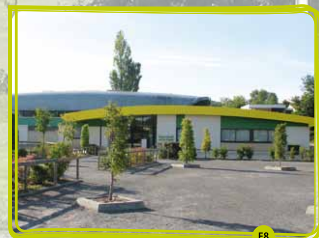
L'Espace Sportif de la Trappe
