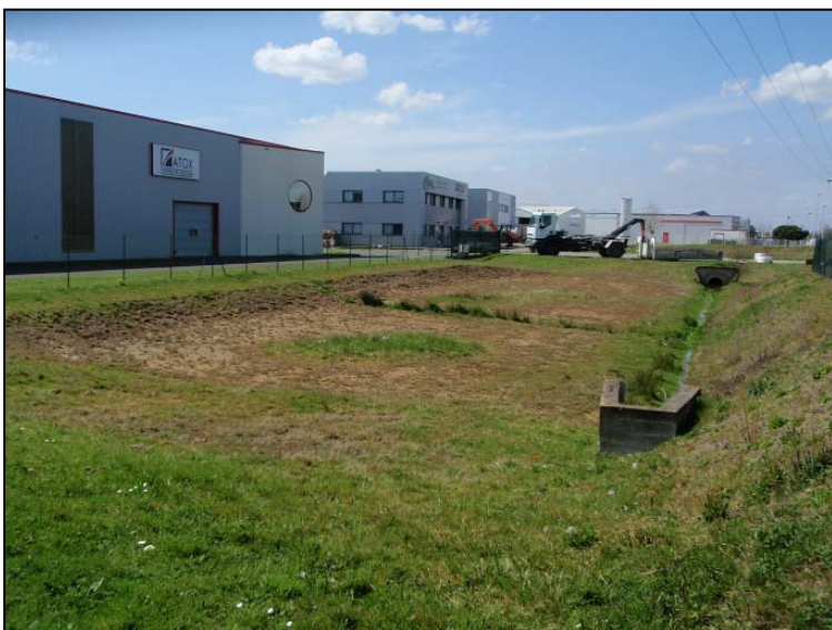
Bassin de rétention végétalisé dans la zone artisanale du Lapin
