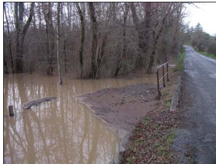
Débordement du Gestas au pont de la Gourgue (Janvier 2009)
