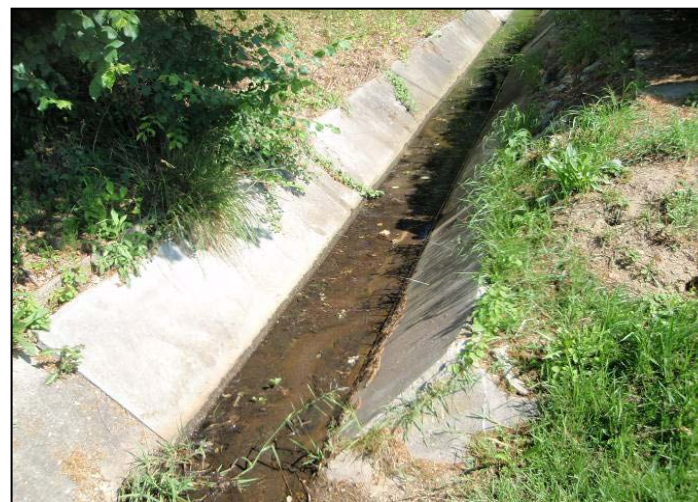
Canalisation du Canterane sur son cours amont à Cailleau
